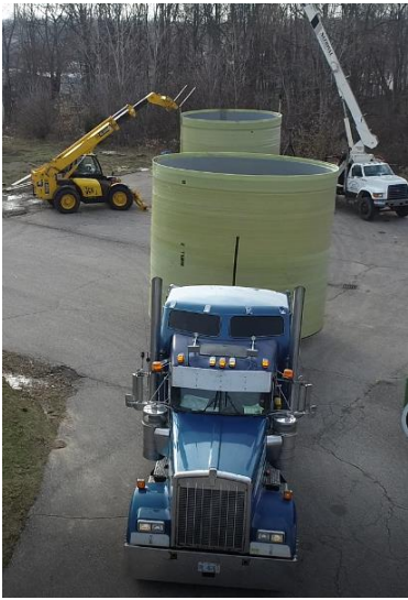
图 1. 4.9 米内径复合管道的运输（进行此类运输需要特定路线并获得交通部门许可）
